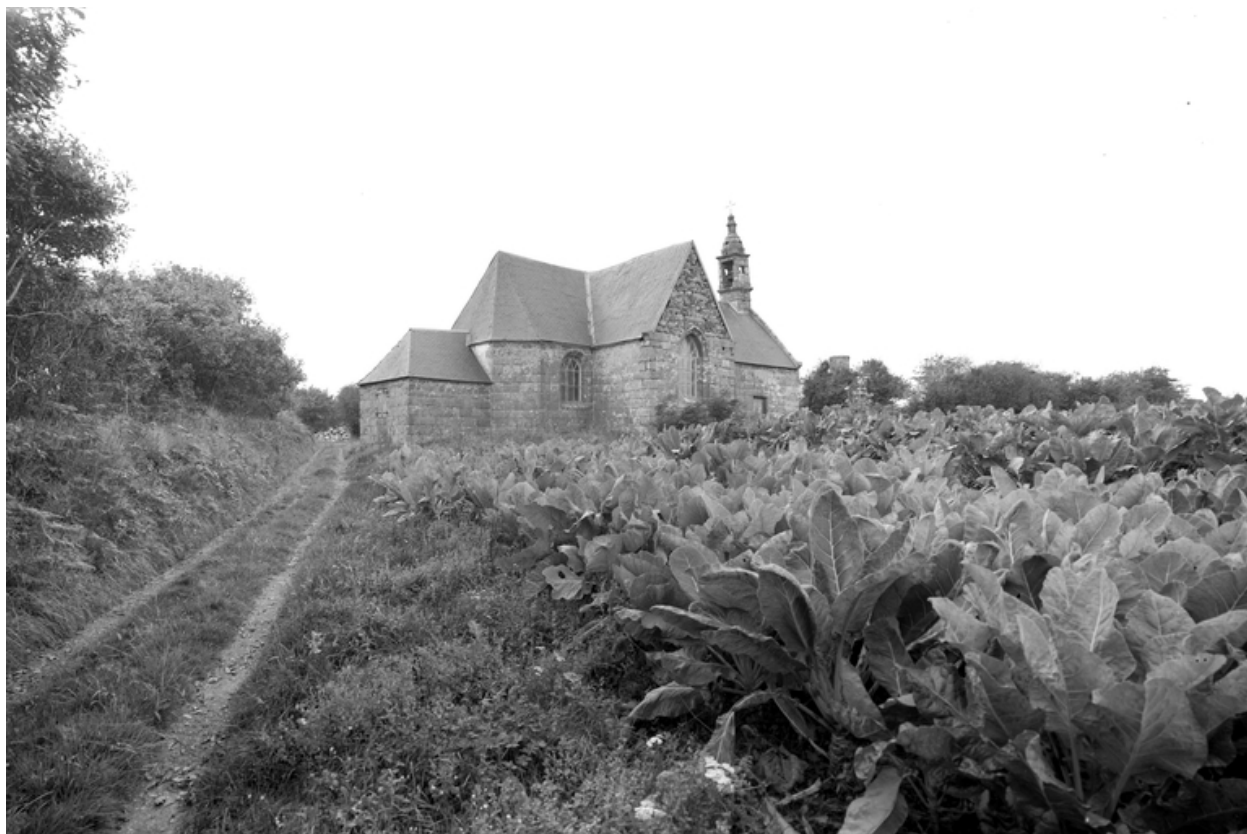
Vue de situation nord-est
