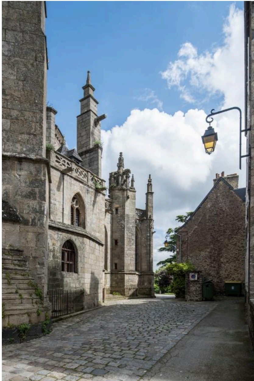
Vue de l'angle du bras sud, de la sacristie et du flanc sud du chevet
