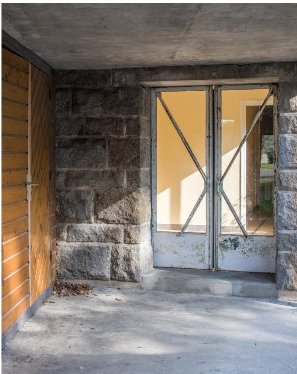
Porte d'entrée. Menuiserie métallique d'origine. Louis Arretche, architecte.
