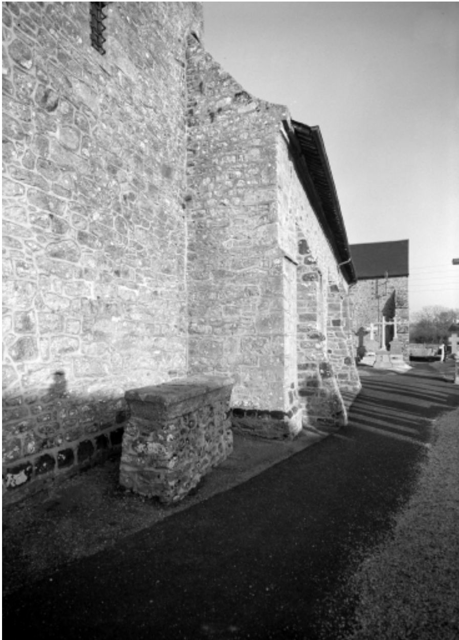
Elévation sud, partie ouest : détail de l'alignement
