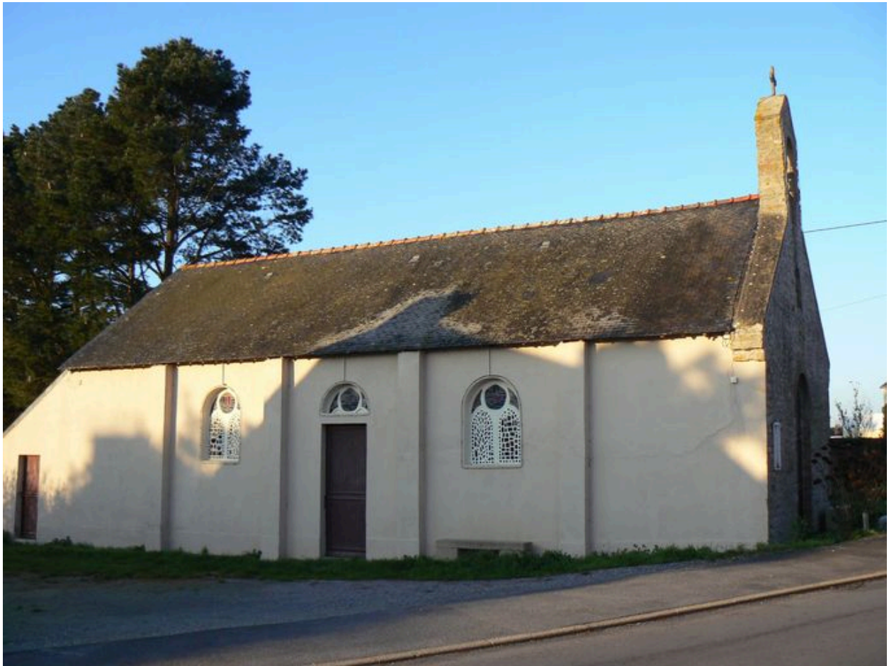
Vue générale de la chapelle Sainte-Anne
