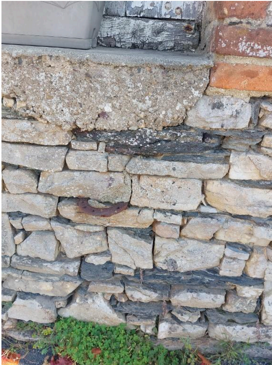
Fer à cheval incrusté dans le parement de la façade principale
