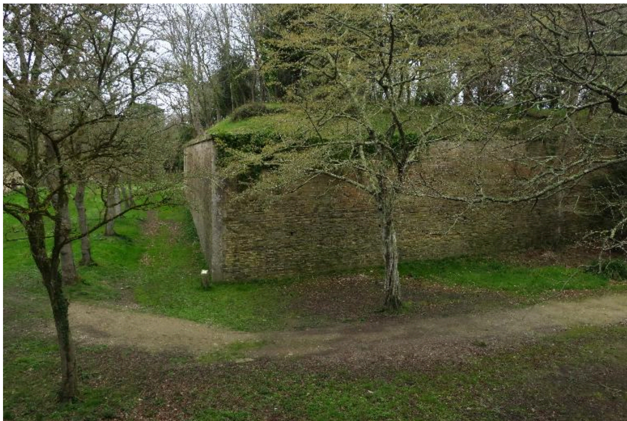
Le Palais, enceinte urbaine, bastion 20, faces et saillant.
