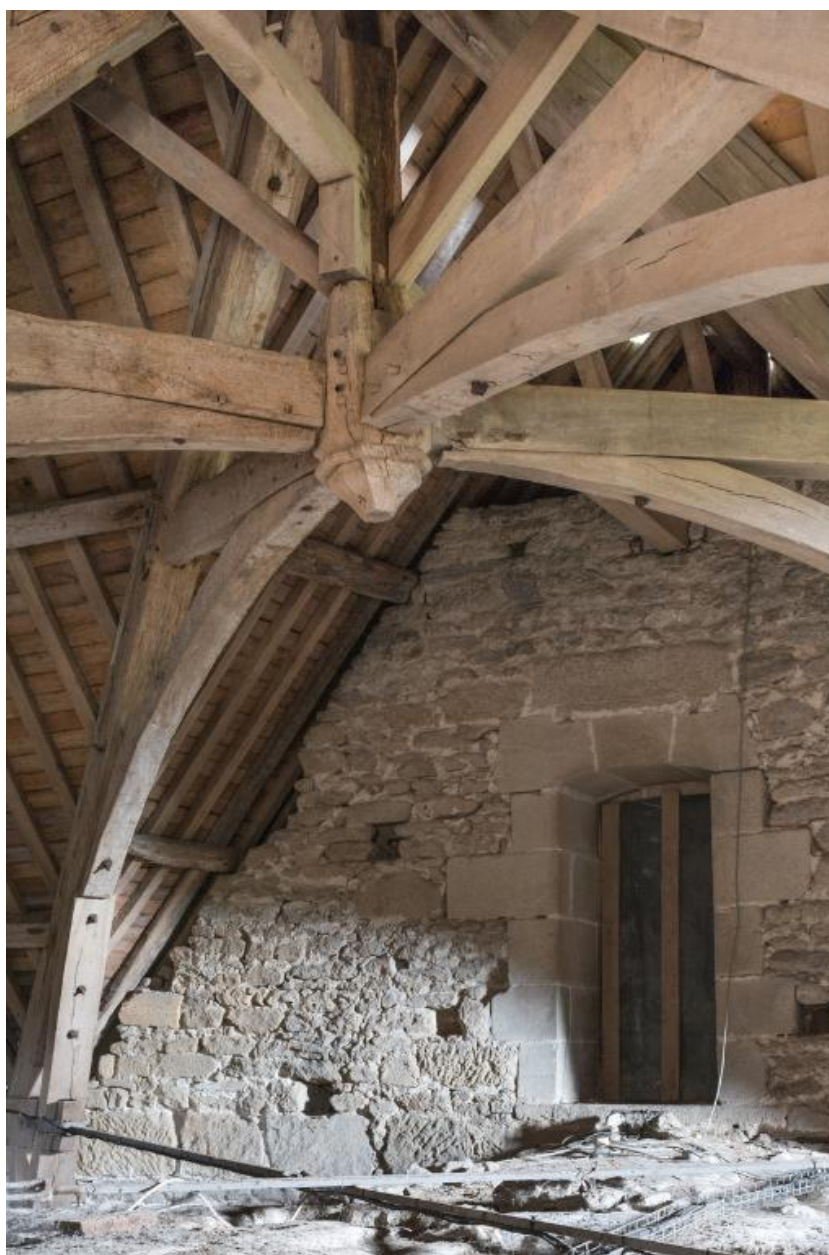
Vue oblique de la charpente à la croisée du transept.
