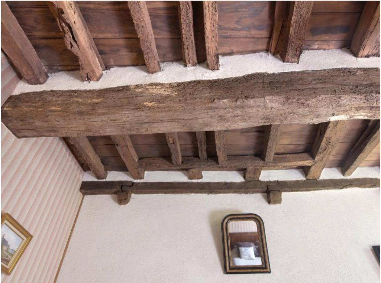
Modification du système d'assemblage au niveau d'un mur de refend, poutraison de l'étage.
