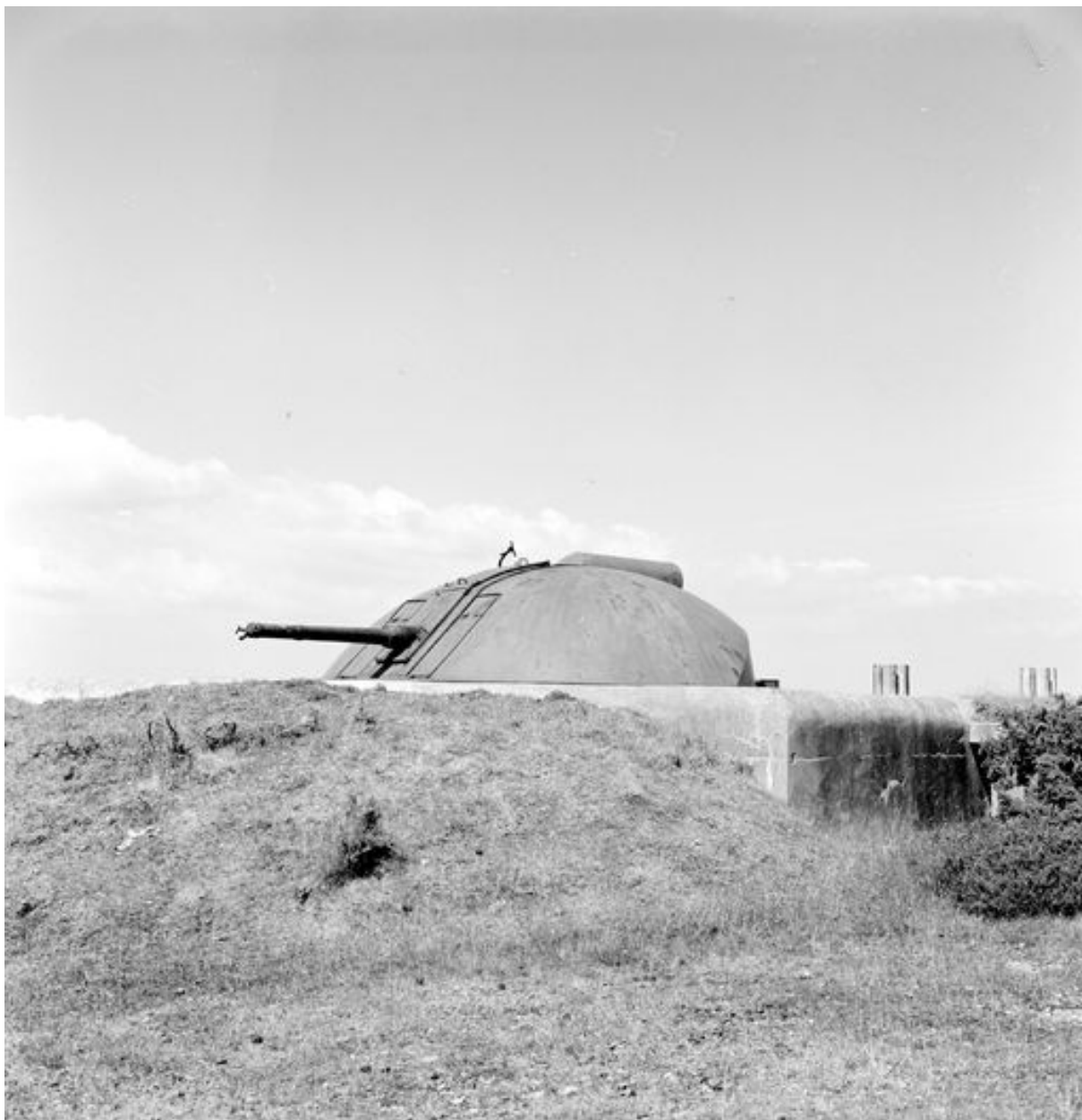
Vue de l'un des quatre canons antiaériens de 10,5 cm sous blindage (état en 1969). Le blindage est de type en calotte sphérique
