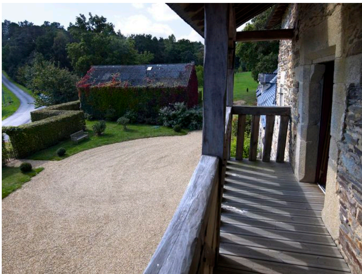
Manoir, logis : coursière en encorbellement (état en 2011)
