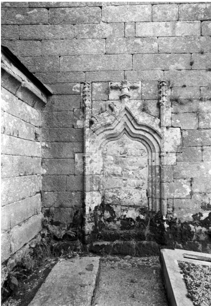
Porte du mur ouest du bras sud du transept
