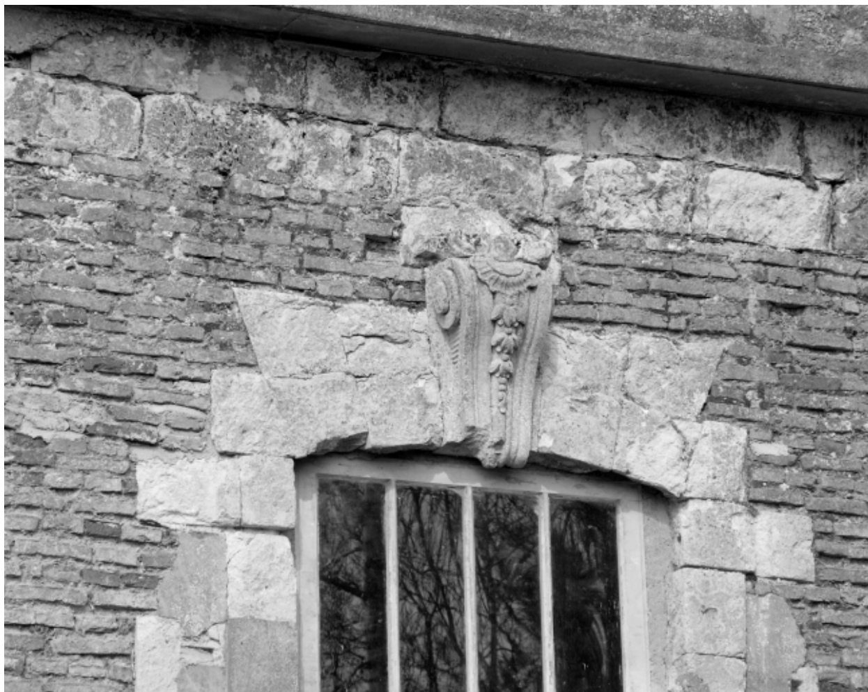
Façade sud ; fenêtre, détail
