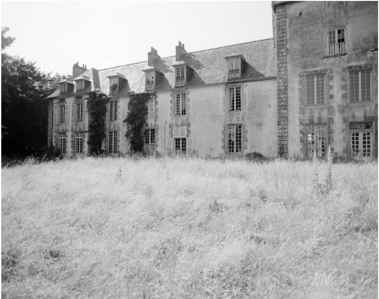
Elévation sud, aile ouest, vue sud-est.
