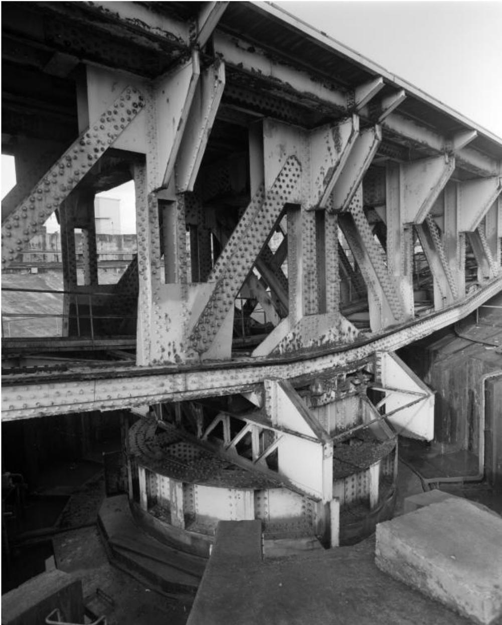
Vue de détail du pont basculant et tournant dans sa fosse bétonnée en 2000 : axe central
