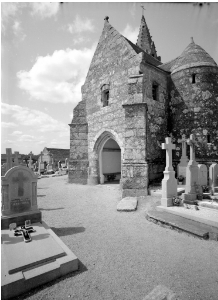
Porche sud pris du sud-est
