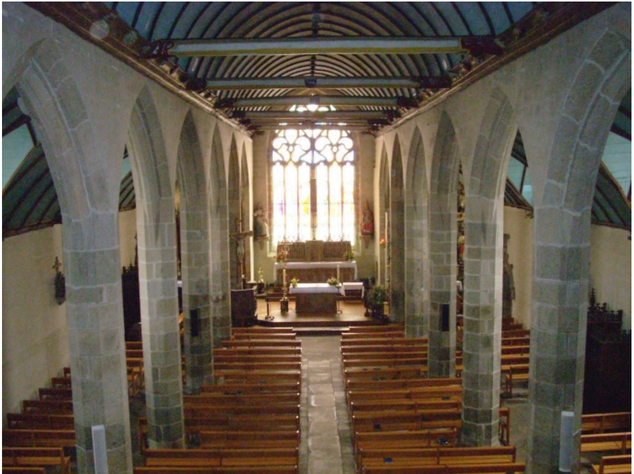
Plonévez-du-Faou, église paroissiale Saint-Pierre : vue axiale depuis la tribune
