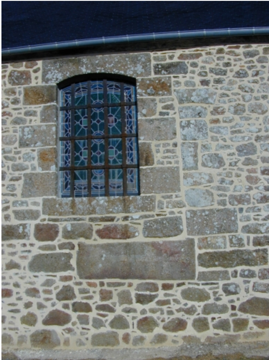
Reprise de l'ancienne fenêtré du choeur : vue générale sud-est
