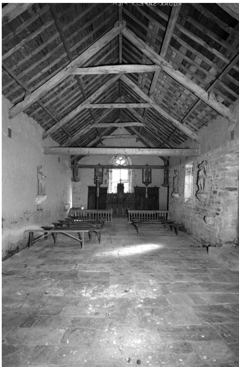
Intérieur : vue générale est
