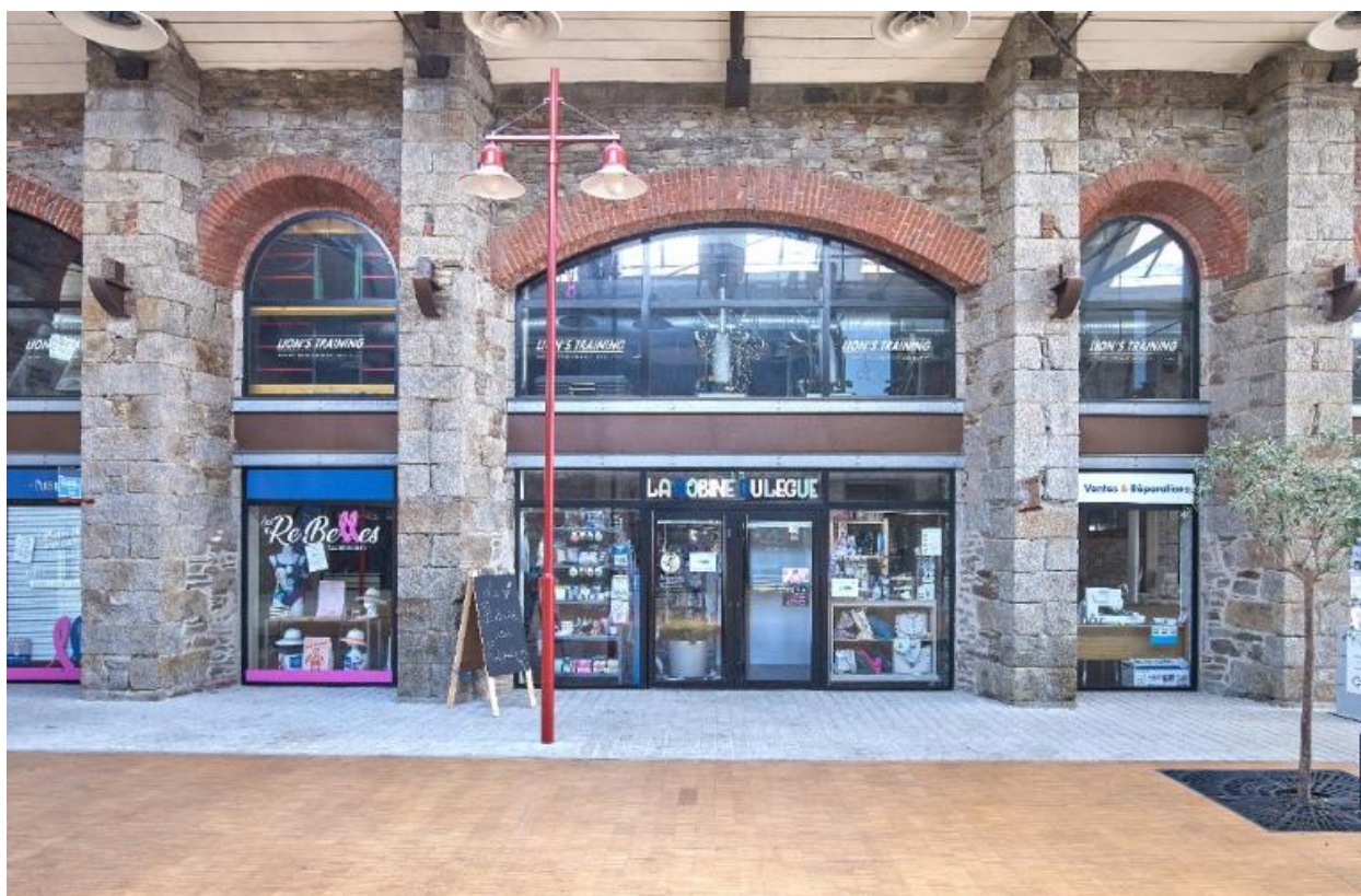
Cellules commerciales installées dans l'ancienne usine
