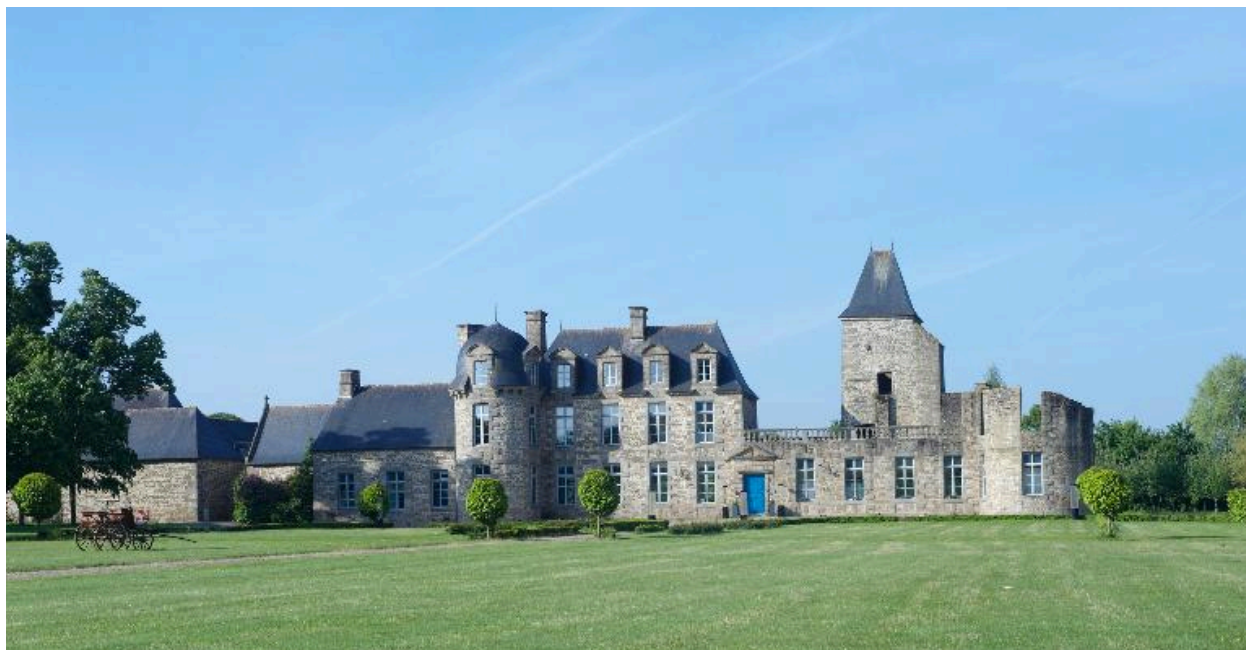
Façade principale nord
