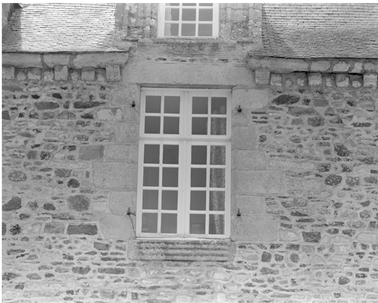
Fenêtre à l'étage
