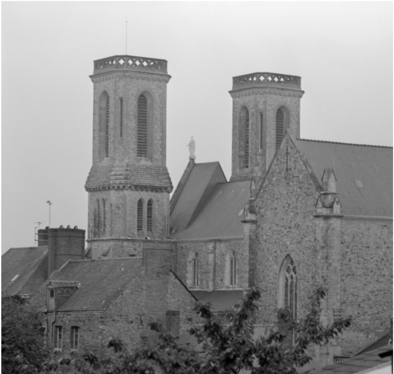
Elévation sud-est : vue générale rapprochée
