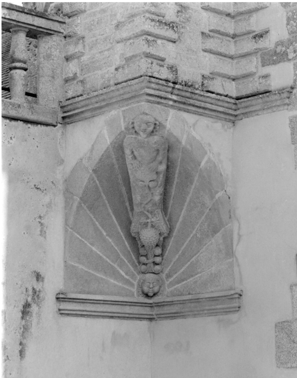
Pavillon droit, détail d'une trompe
