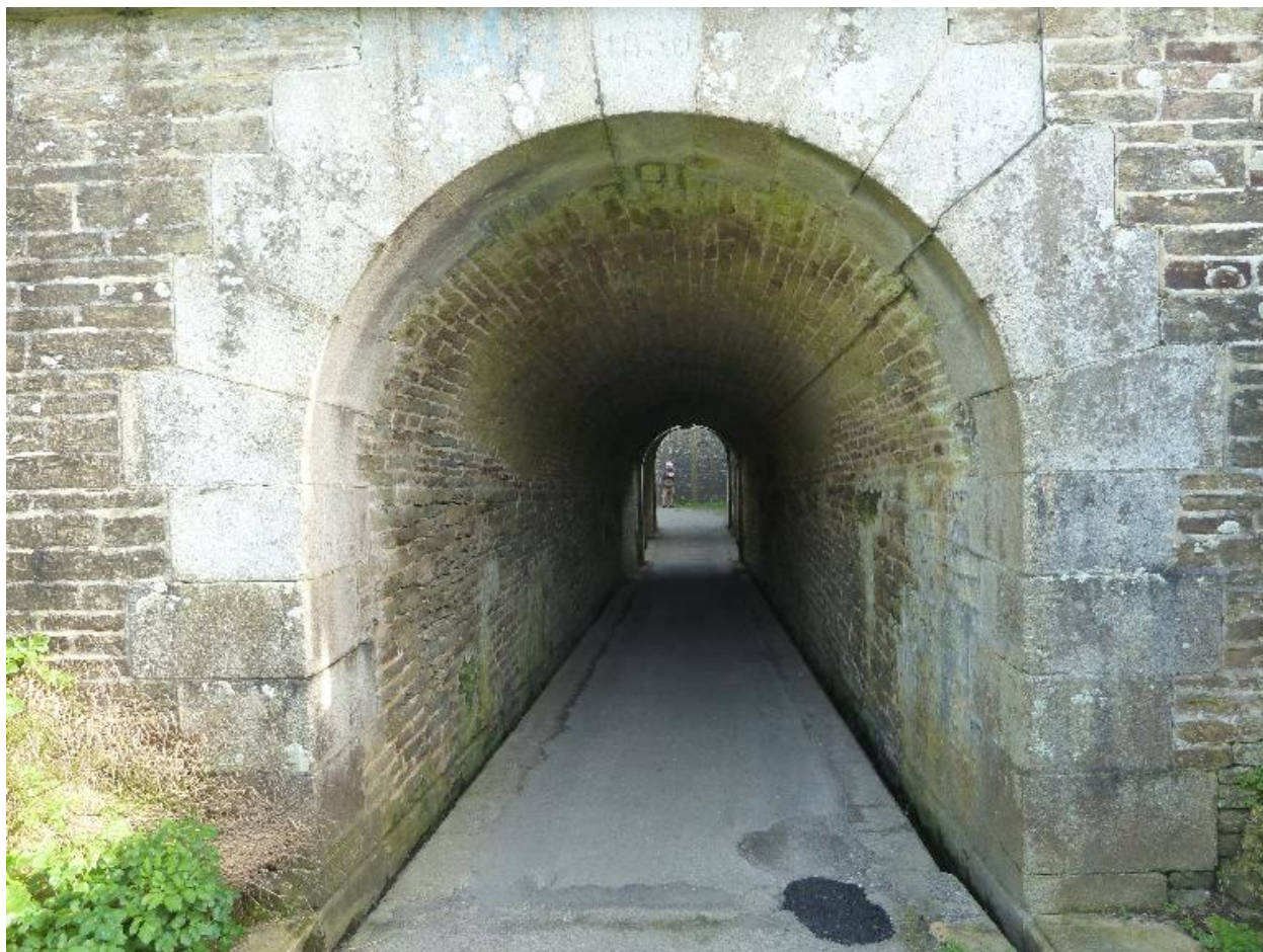
Le Palais, enceinte urbaine, porte de Locmaria, débouché côté ville.
