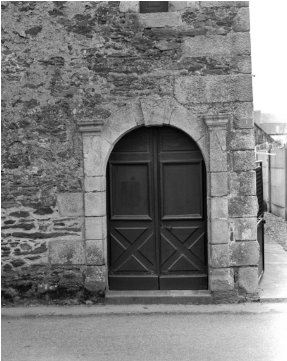
Elévation ouest, porte ; vue générale
