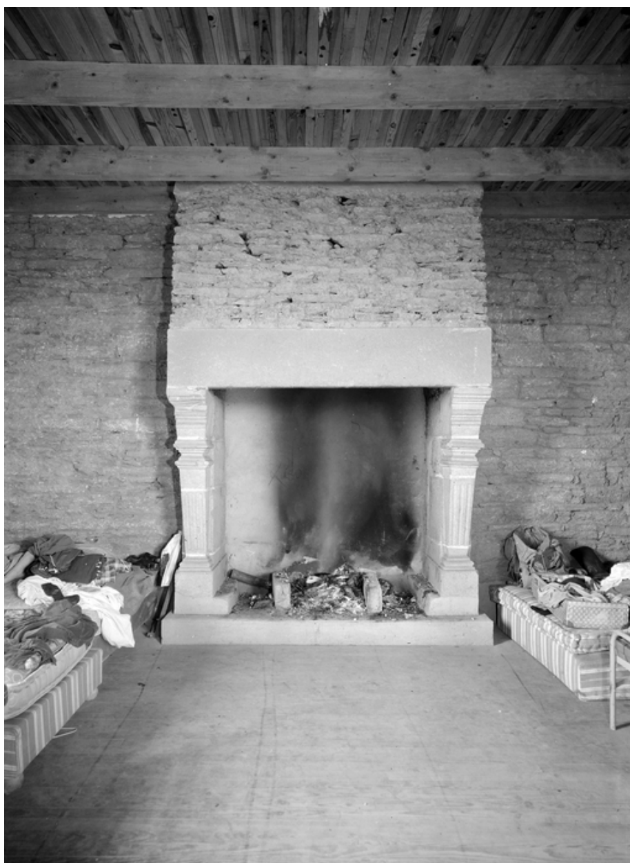
Cheminée du premier étage
