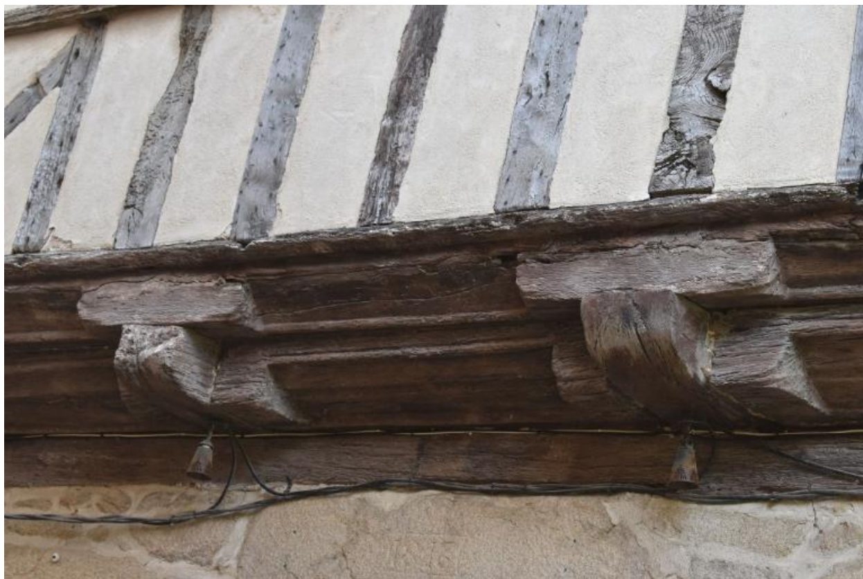
Détail des sablières d'encorbellement et des solives
