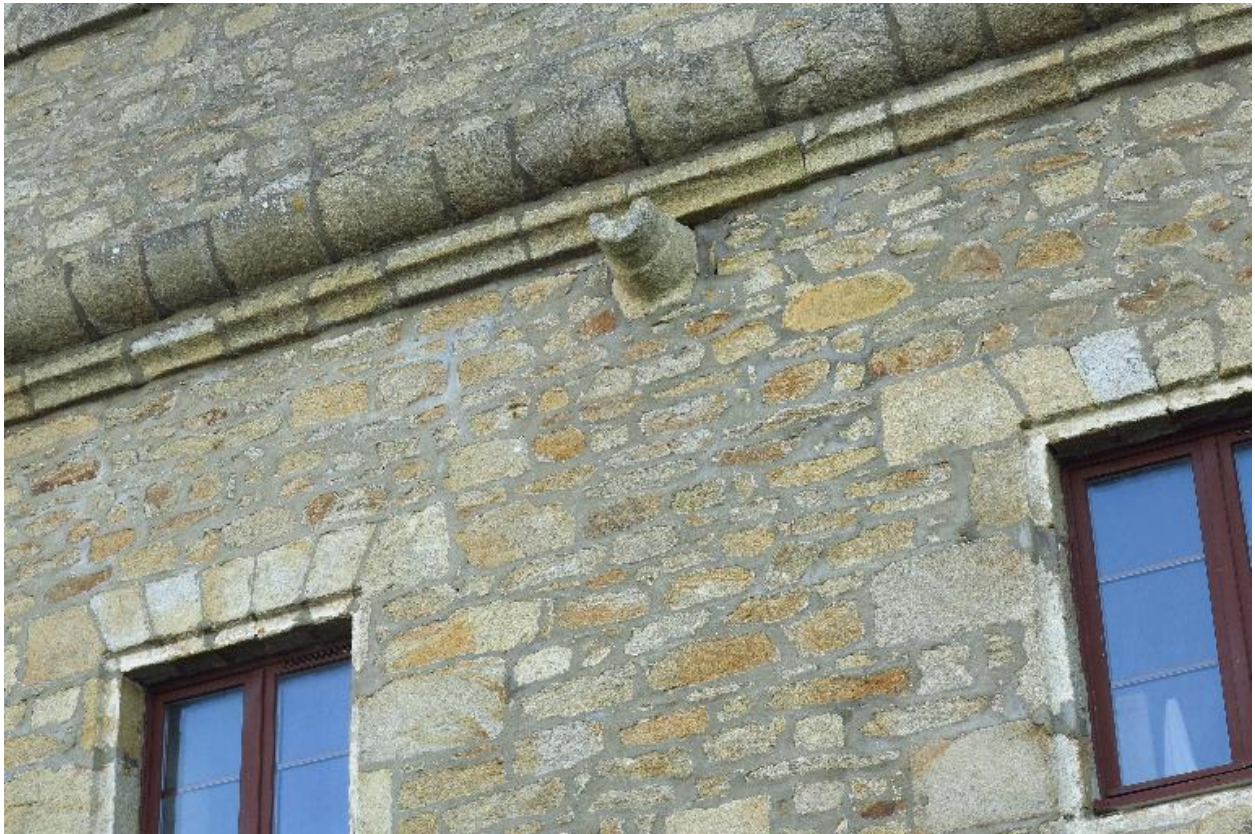
Saint-Pierre-Quiberon, fort de Penthievre, caserne défensive, détail de la façade nord-ouest.
