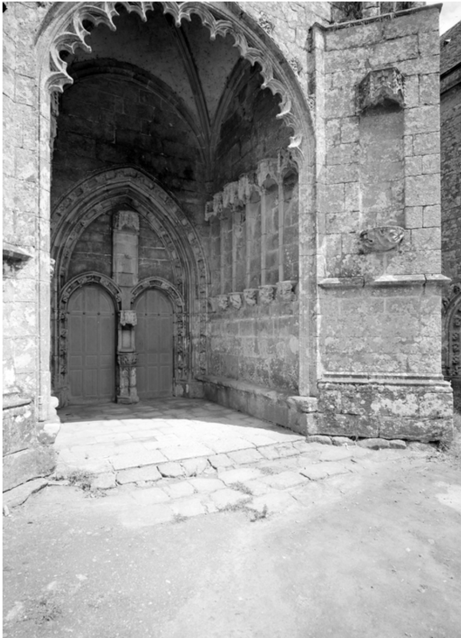
Façade sud, le porche, vue générale intérieure.
