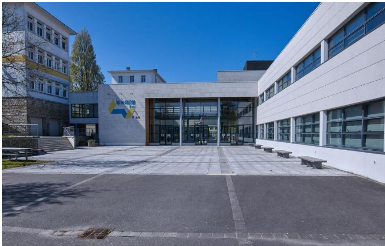
Entrée du lycée, façades ouest et externat, façade sud (vue prise de l'ouest). Archipole Urbanisme et Architecture, 2005. A gauche, pignon nord de l'externat du lycée Jules Lesven (J-B. Mathon, architecte).
