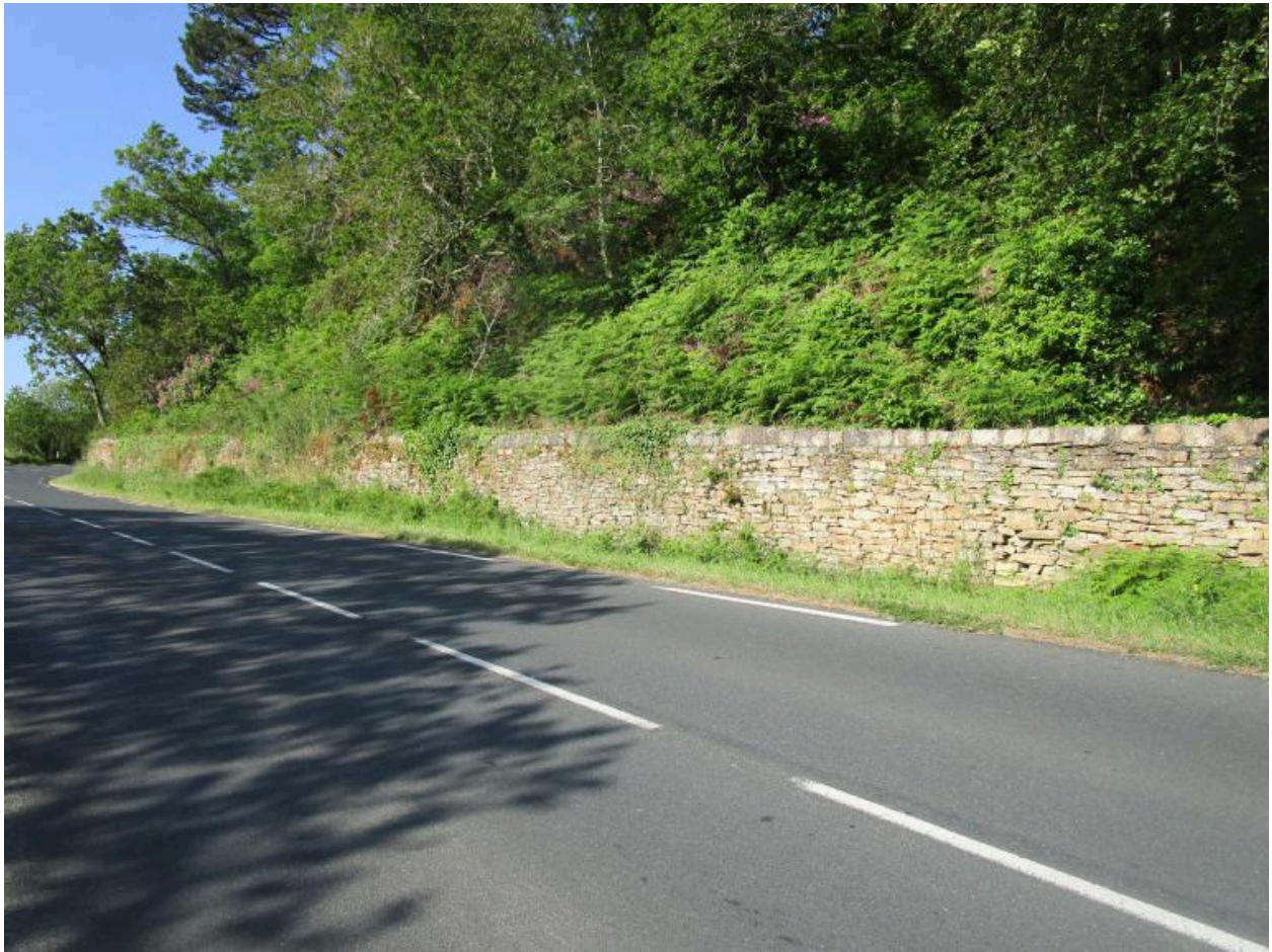
Mur d'enceinte au nord-est du domaine. (2023)
