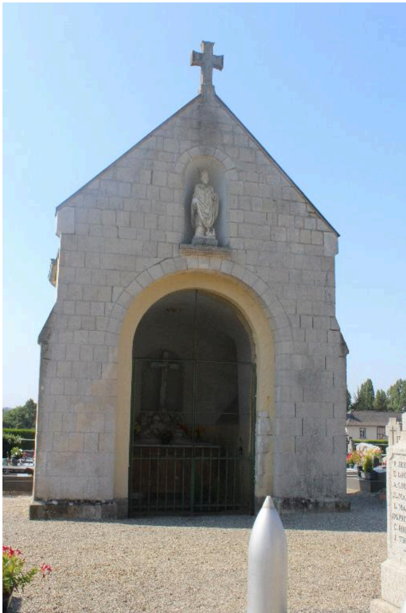
Façade principale : vue générale
