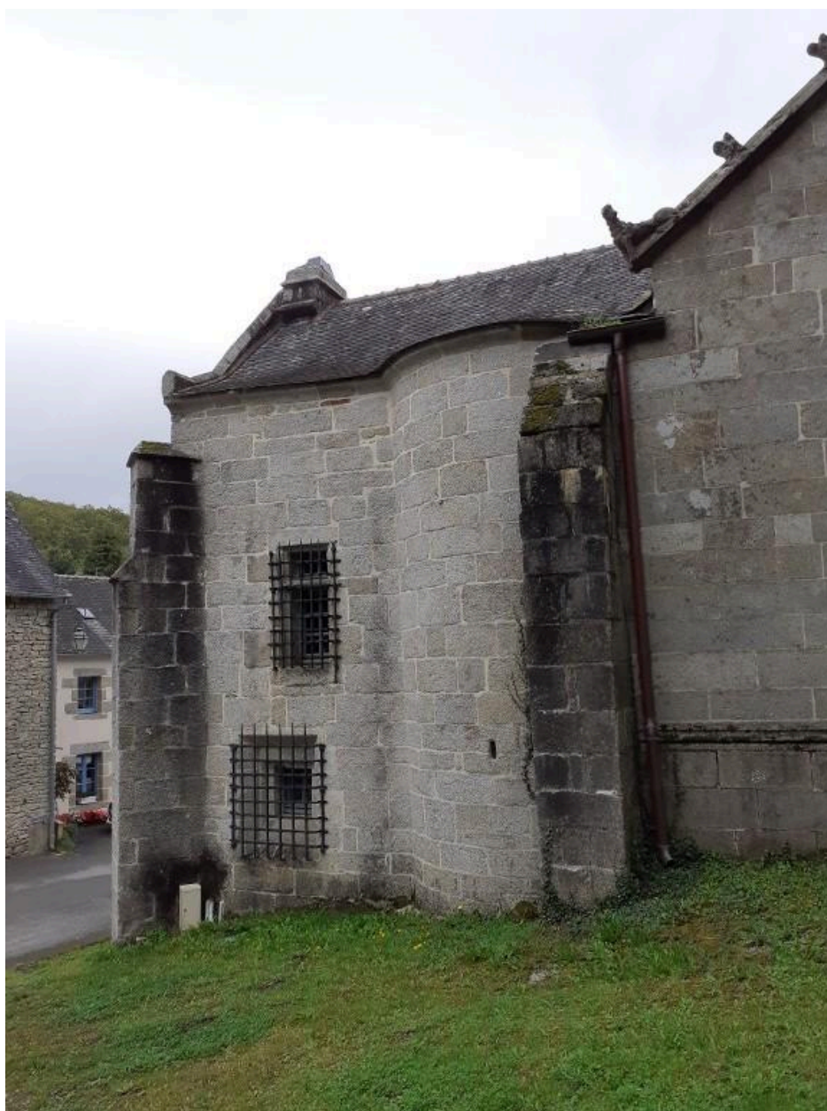
Sacristie, vue depuis l'ouest
