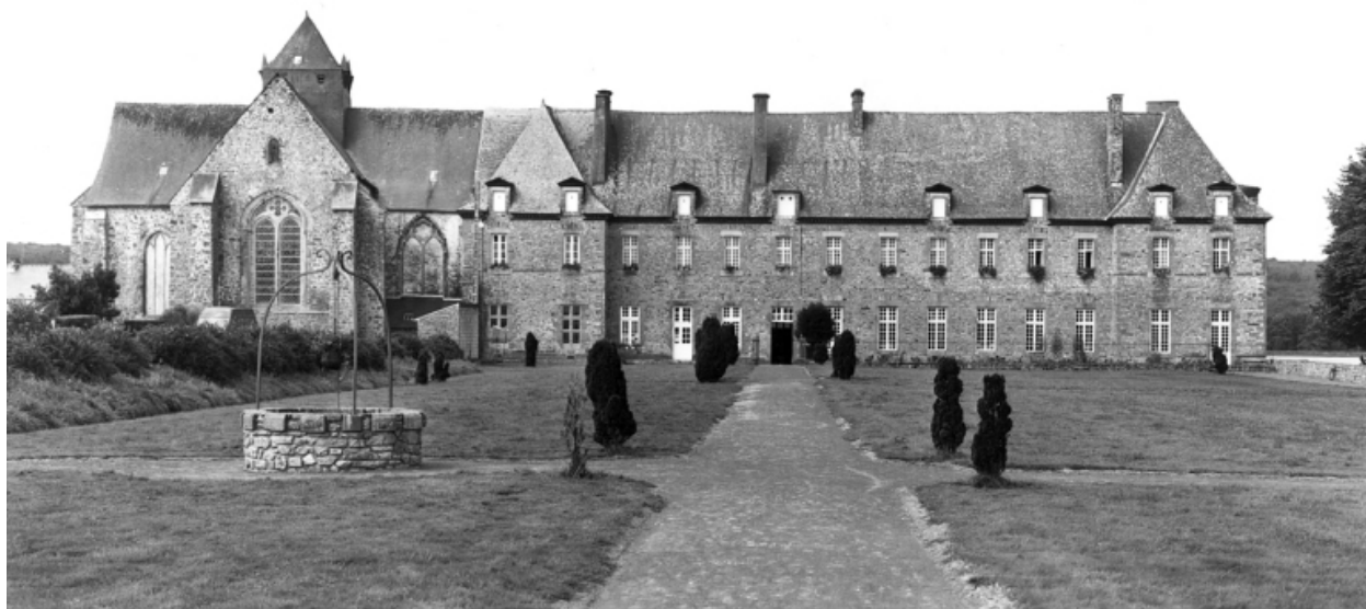
Vue générale prise vers l'ouest
