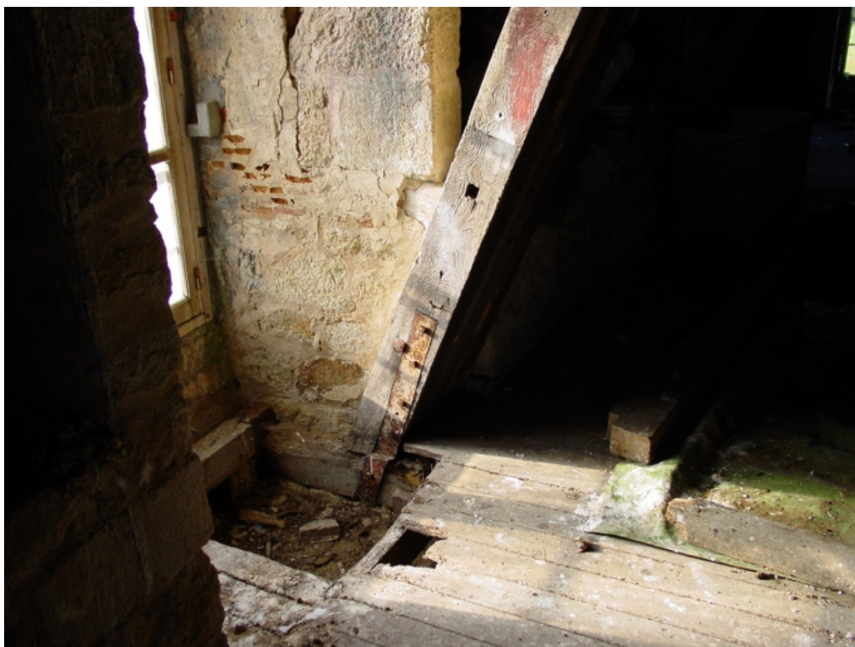
Donjon, charpente. Détail renforts en moises et pattes métalliques en pied de ferme.
