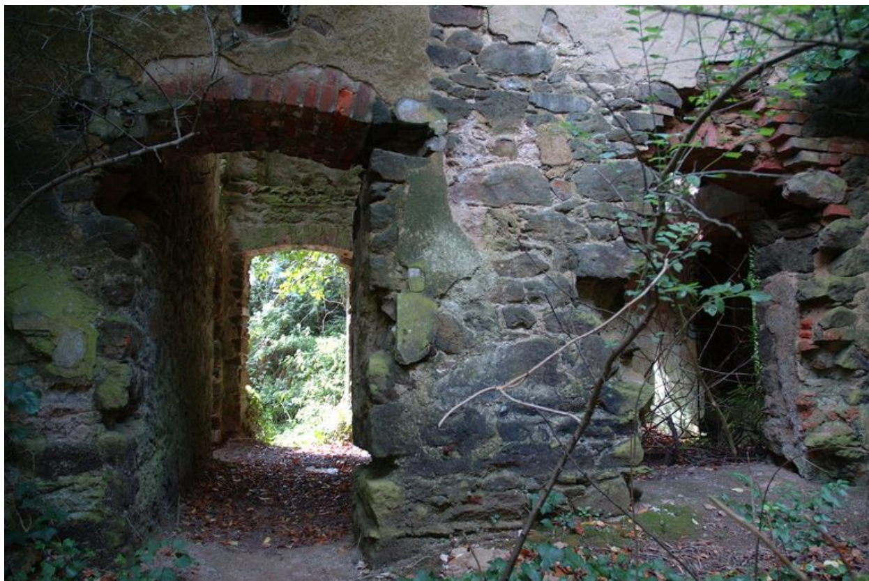
Vue de la caserne (état en 2007)
