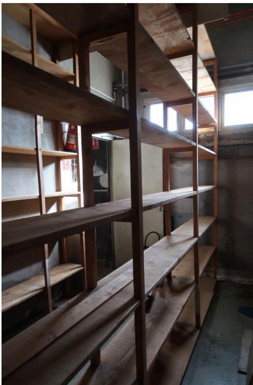
Intérieur, rez-de-chaussée, zone stockage, étagères
