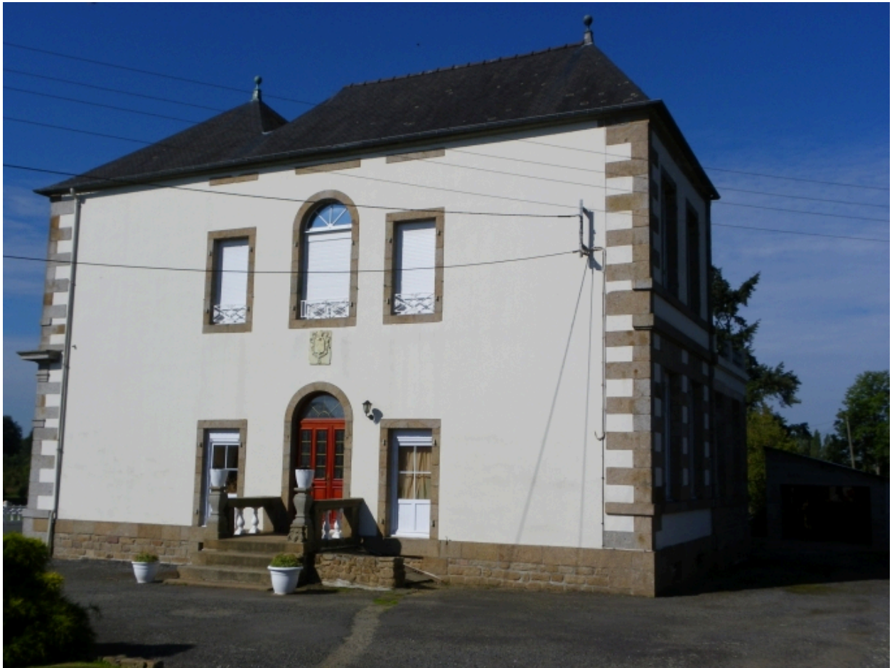
Façade est de l'ancien château.
