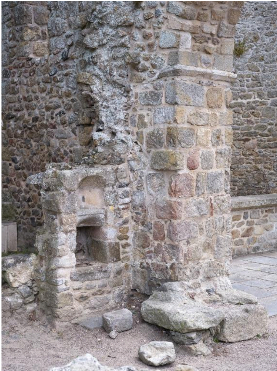
Abside orientale, vestiges
