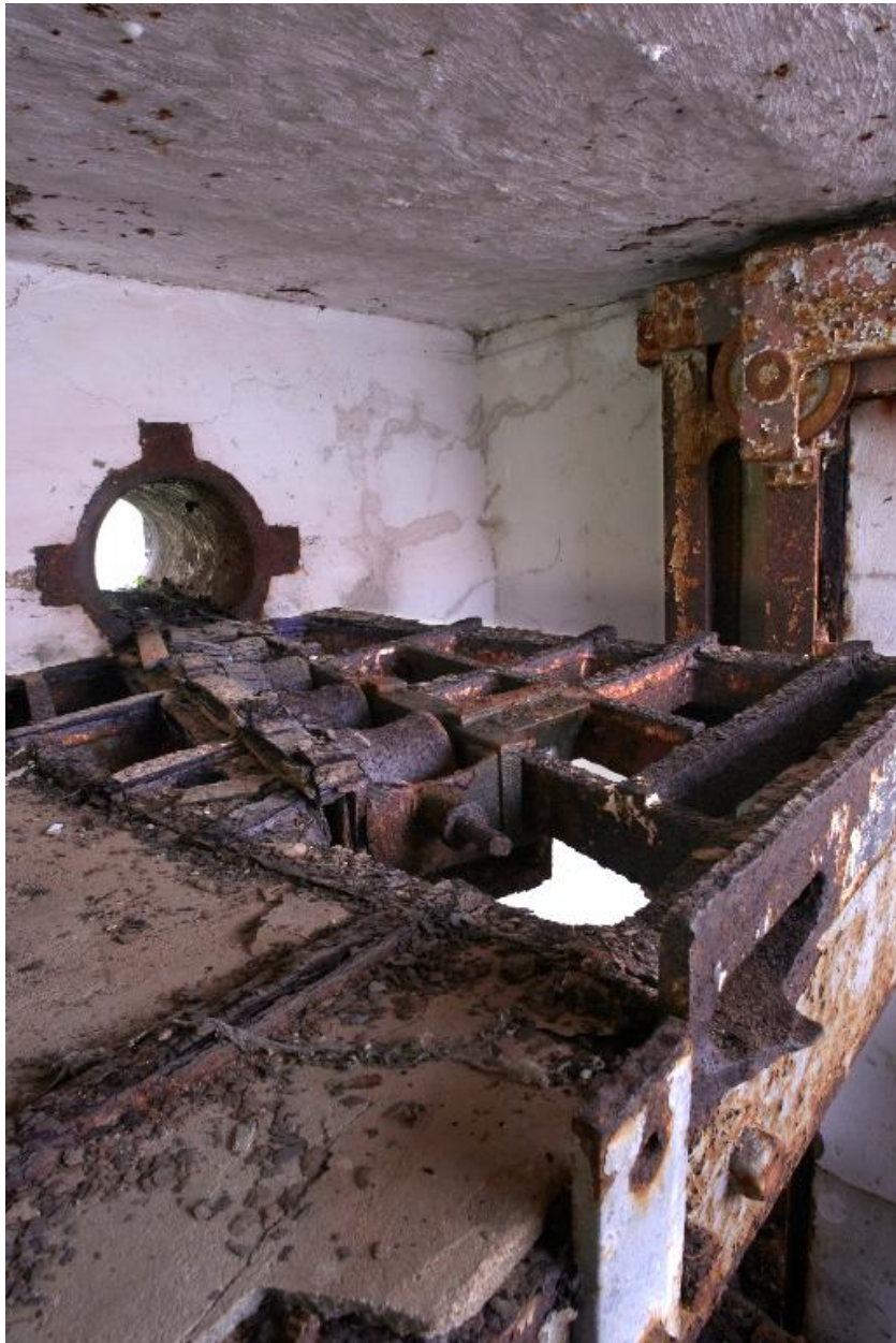
Vue intérieure de l'un des magasins de combat : passe-obus sur galets (état en 2009)
