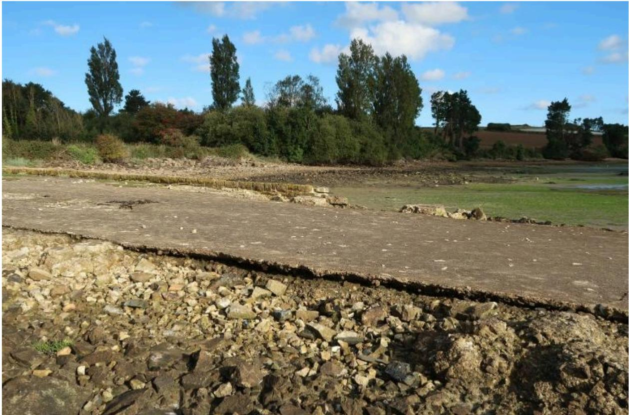
Vue de détail de la partie supérieure : dégradation du béton armé de la couche supérieure et de la maçonnerie par l'érosion marine
