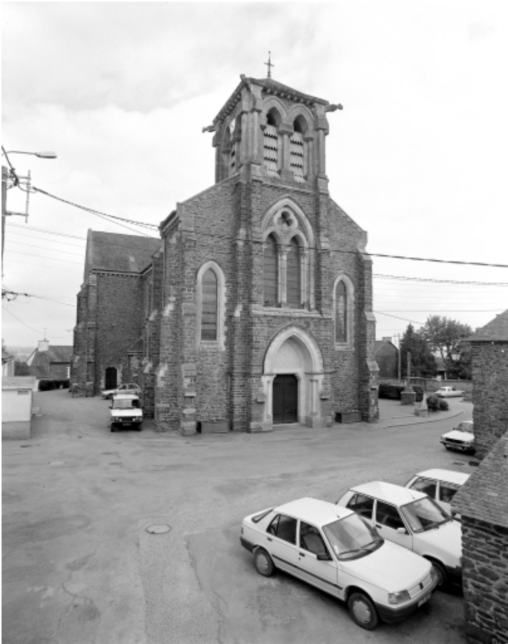
Elévation Ouest : vue générale
