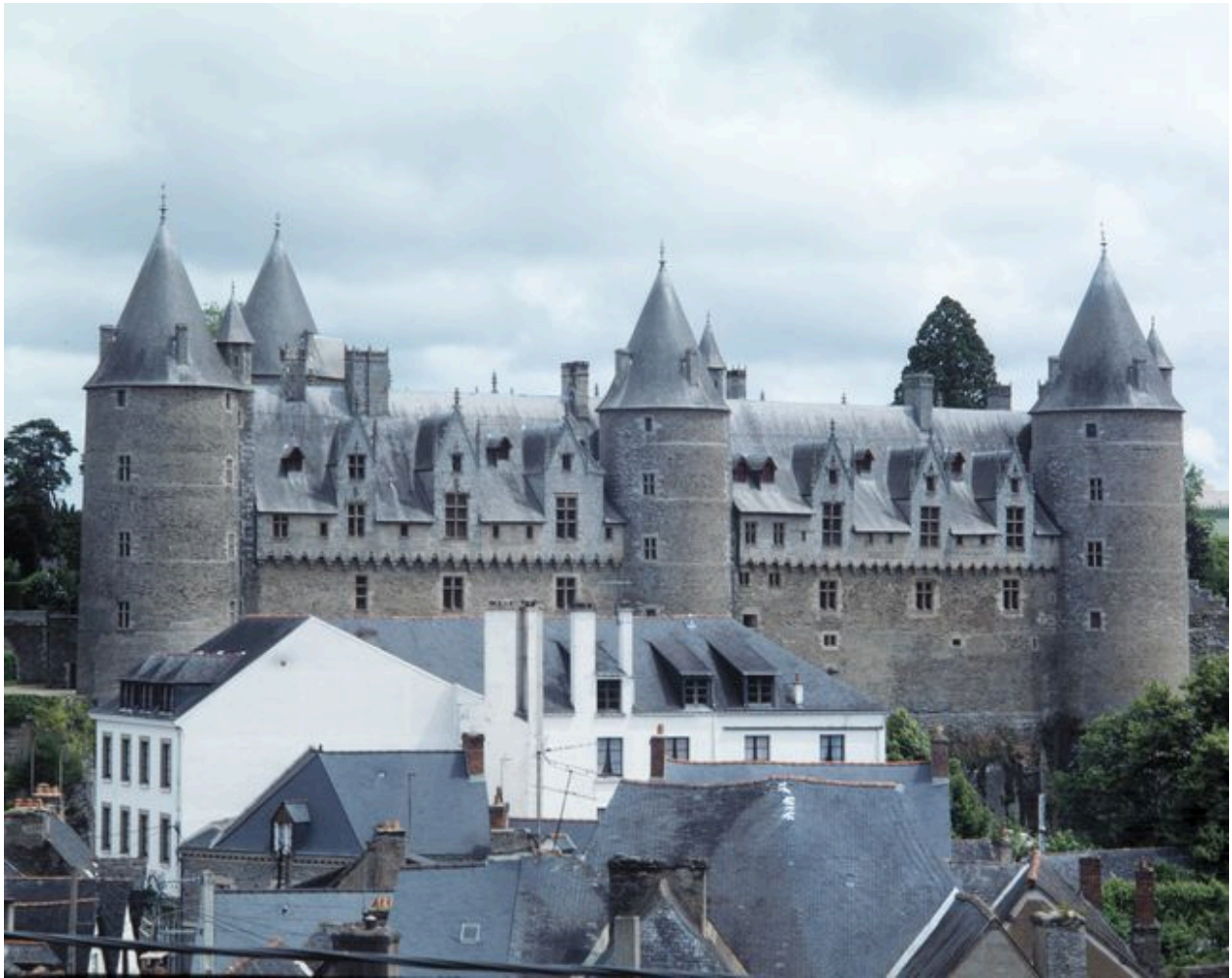
Elévation sur rivière : parties hautes prises de l'ouest
