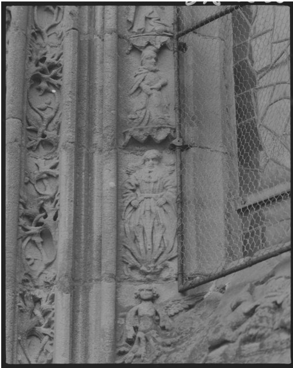
Porche nord, ébrasement gauche
