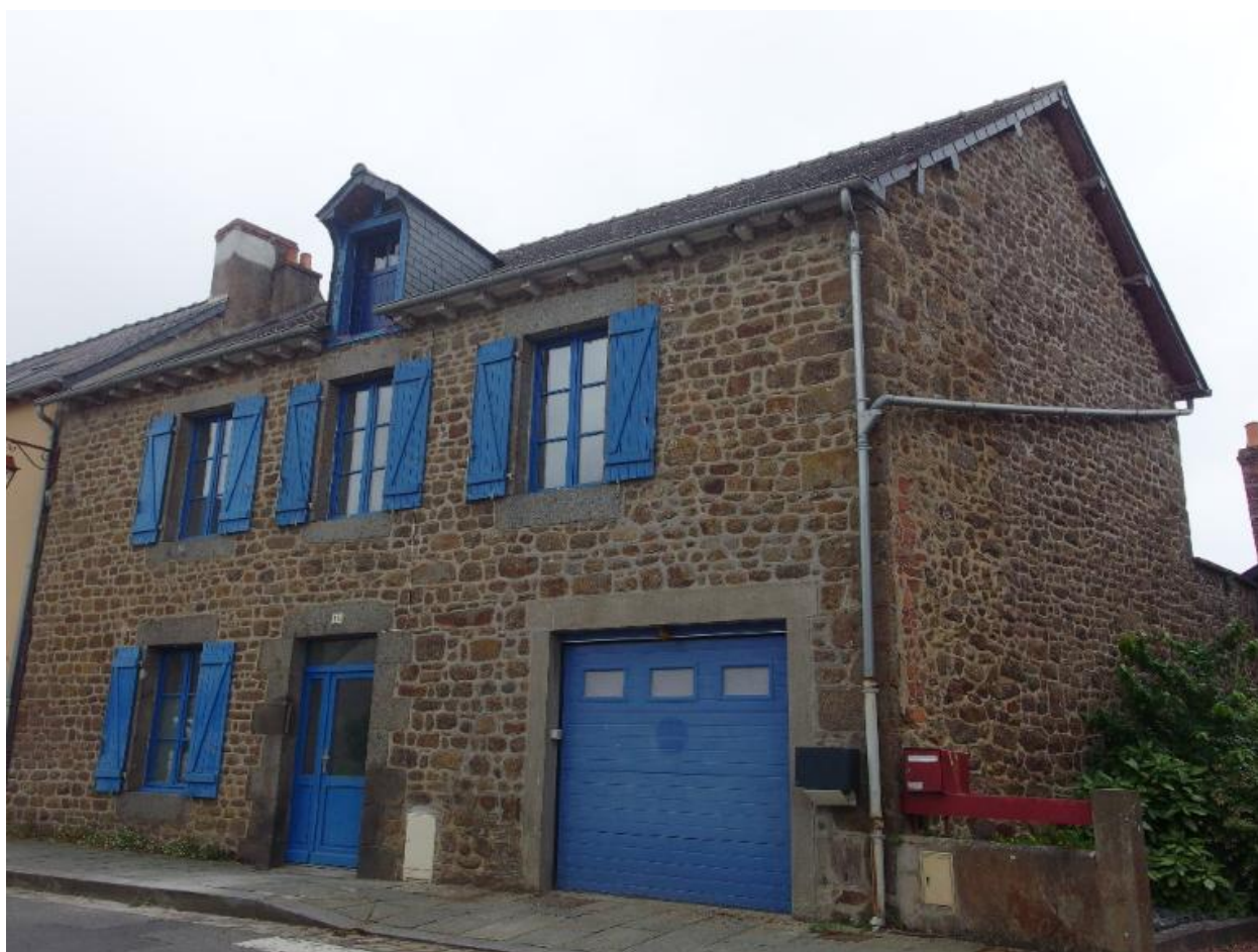
Vue de la façade est
