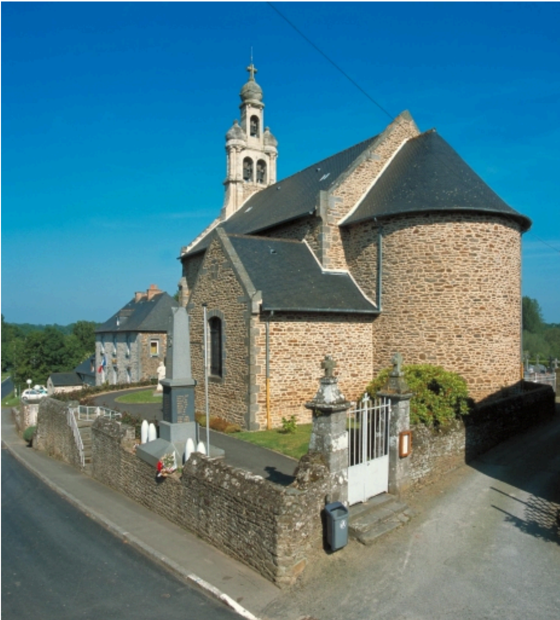
Vue générale est
