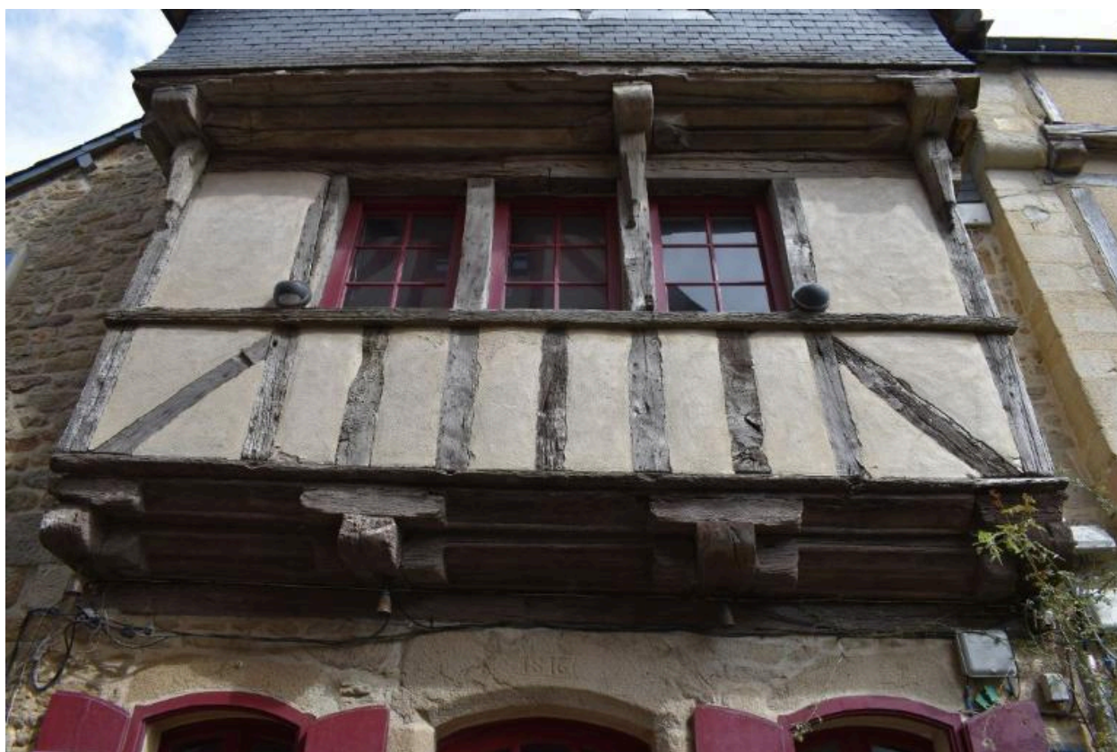
Détail des sablières d'encorbellement moulurées
