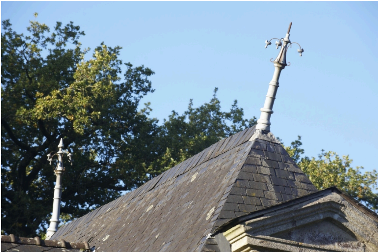
Epis de faitage situés sur les communs
