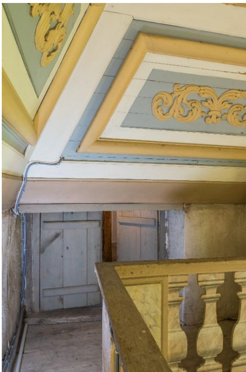
Escalier monumental: accès à la balustrade et départ du plafond caréné
